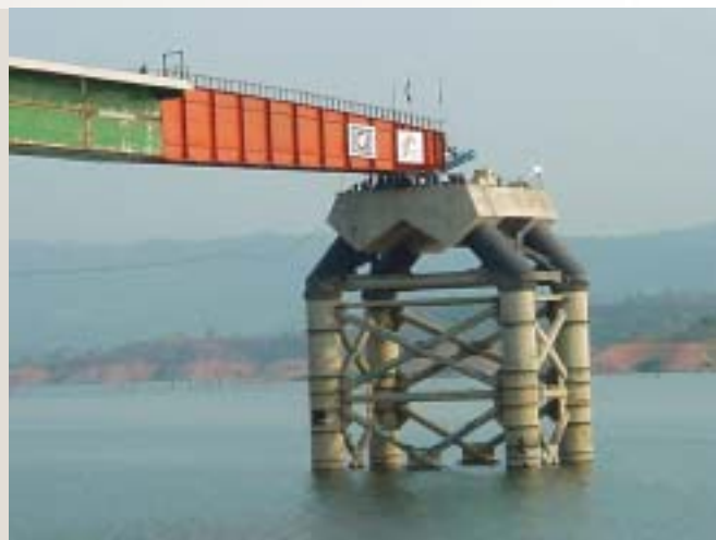
Figura 2. Subestructura tipo jacket. En el caso del puente Chiapas el principal reto consistía en hacer llegar la superestructura a través de los ocho claros, algunos de los cuales tenían voladizos de hasta 168 m, que fue la mayor dimensión utilizada en el mundo hasta el momento de su construcción (figura 3). Por otra parte, el claro de 92 m representa un récord para las longitudes de empujado realizadas en México.
